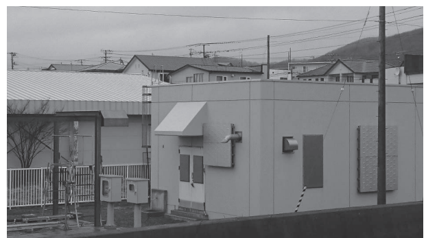
3.11の際、浸水のあった本町ポンプ所
