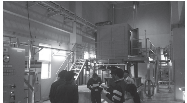
浄化センター内部の様子
