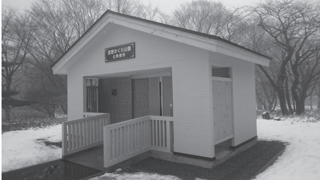
新しくなったさくら公園公衆トイレ
