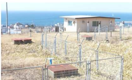
本町地区にある西部簡易水道配水池
