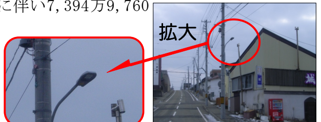
本町地区のLED防犯灯
