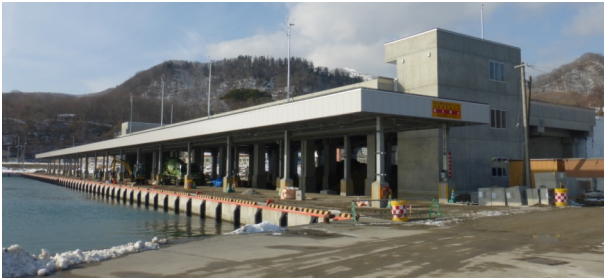
平成31年度供用開始を目指し建設が進む庶野漁港水産物荷捌施設
