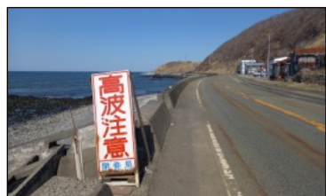
なぎのいい満潮時でも越波している近浦～笛舞間の国道
