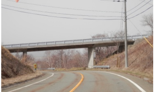
解体される追分峠「無名橋」
