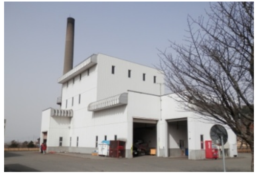
老朽化が激しく、一部改修される清掃センター
