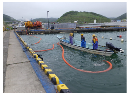
えりも港で海底に堆積したイワシを清掃ポンプ車で汲み上げる作業
