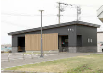
防犯カメラの設置が予定されている灯台公園トイレ
