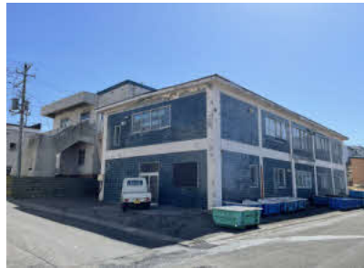
隣接しているため同時でなければ解体できない2つの建物
