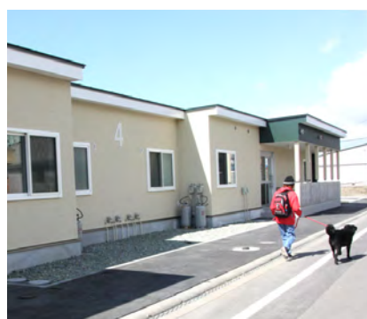
公営住宅建て替えのため、平成27年9月に着工し平成28年2月に完成した大和C団地4号棟(平屋建て1棟4戸)
