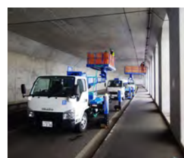
広尾町モエケンでの覆道補修工事
