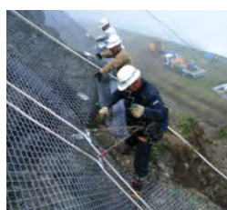
広尾町フンベでの金網設置工事
