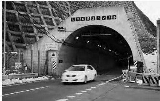
2月に開通した「えりも黄金トンネル」
