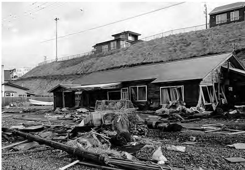
多くの家屋などが被害を受けた
