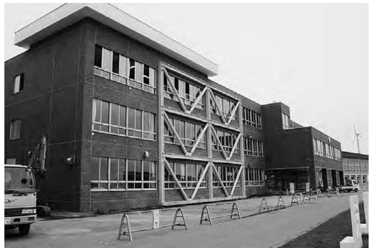
平成22年に耐震化工事を終えたえりも中学校
